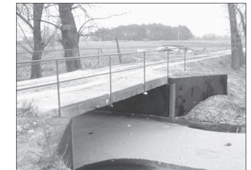
Most w Łęgu po remoncie
