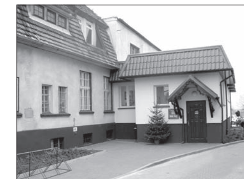
Przebudowane wejście do Urzędu Gminy w Czerminie
