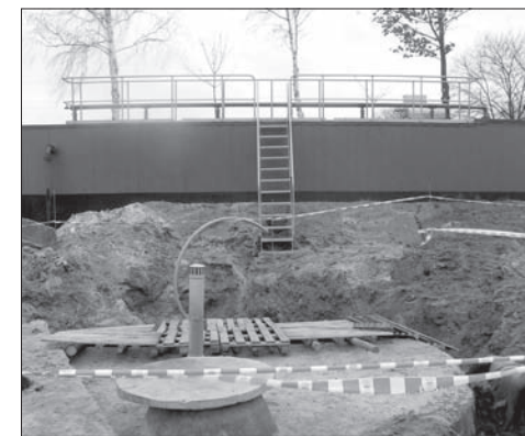
Biologiczna oczyszczalnia ścieków w Czerminie w trakcie budowy
