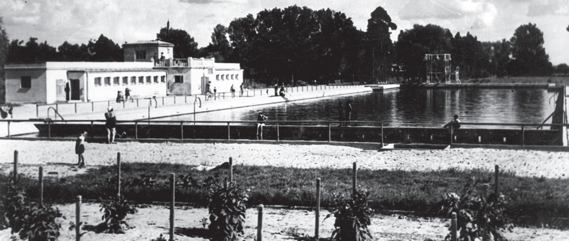
83. Basen kąpielowy Szkoły Podchorążych Piechoty w Komorowie, wybudowany z inicjatywy komendanta Bocińskiego
