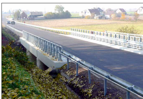
Wyremontowany most w Fabianowie
