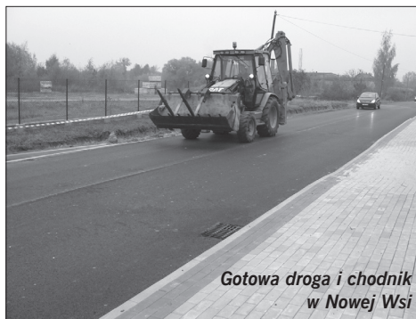
Przebudowa drogi Nowa Wieś - Taczanów II
