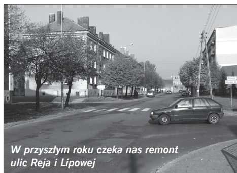
Gotowa droga i chodnik w Nowej Wsi
